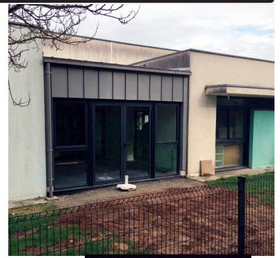
L'extension a été réalisée entre deux salles.
